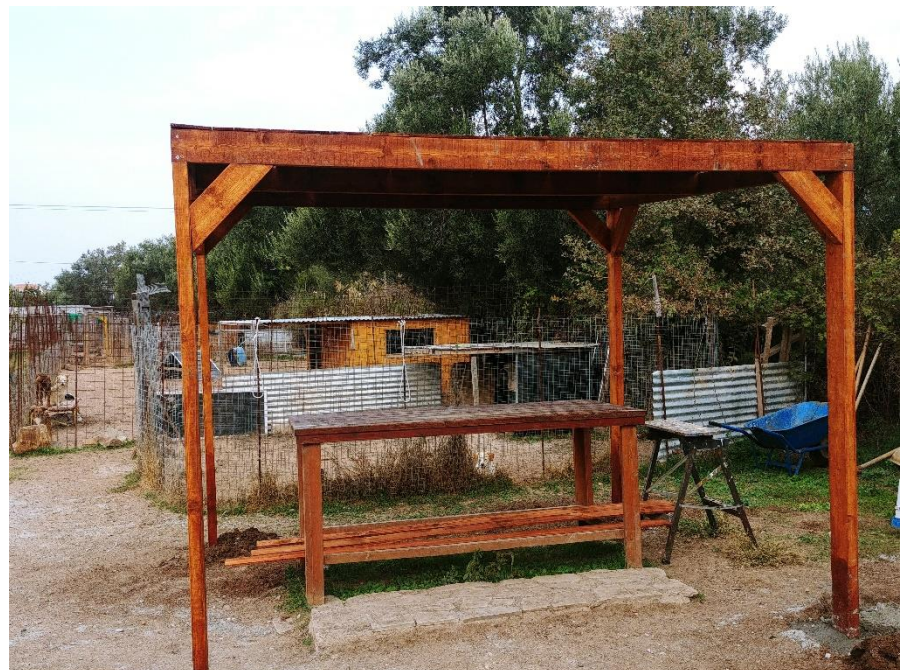
Das Dach steht! Im Frühling werden Bambusrollen als Sonnenschutz angebracht ... ein Regenschutz wird bei Bedarf angebracht...Danke, Danke, Danke!
